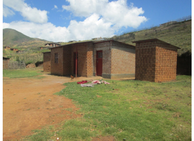
L'activité minière est la cause de nombreux troubles pour les habitants. Des personnes délocalisées par Twangiza Mining sont relogées dans ces maisons de fortune construites à Cinjira, 2015 (Photographie et collection CERN).
